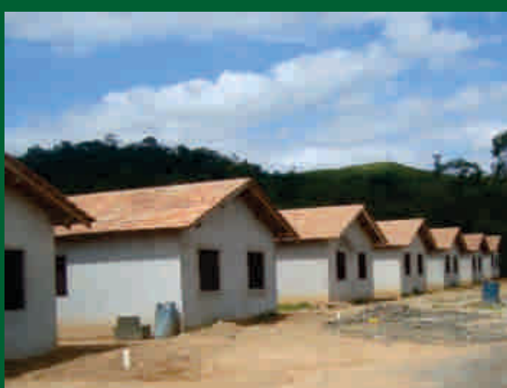
Município: Pouso Redondo Nº de unidades: 30 em execução Valor do investimento: R$ 525 mil
