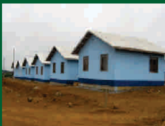
Município: Capão Alto Nº de unidades: 30 (18 em execução) Valor do investimento: R$ 557 mil
